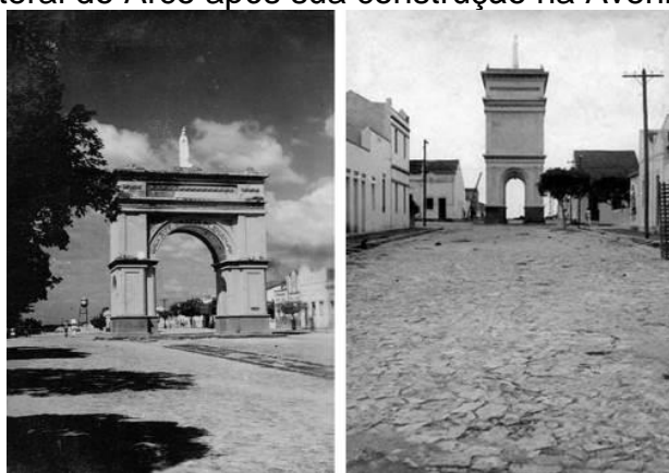
Figura 8: Frontal e lateral do Arco após sua construção na Avenida Boulevard Pedro II.
