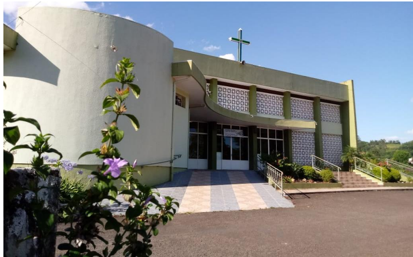
Imagem 03: Vista da Igreja Atual
