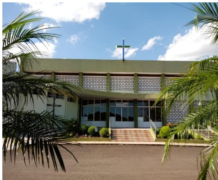
Imagem 07: Identificação dos vitrais na Fachada Frontal
